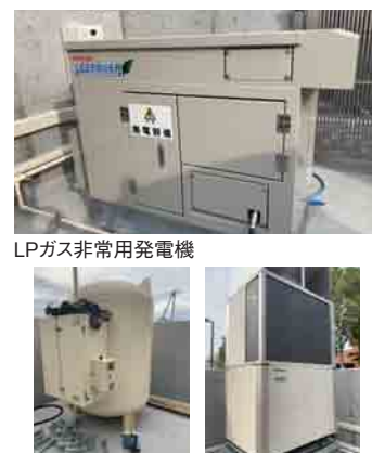
LPガス災害バルクとGHP(ガスヒートポンプエアコン)
