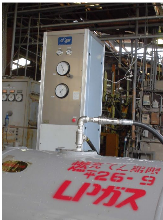
写真4 非水槽式で3.8MPaに加圧し耐圧試験
